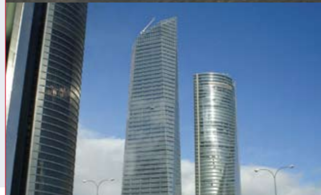
MADRID: Alquiler de una fregadora METRO en los aparcamientos de la torre de cristal en Madrid.
